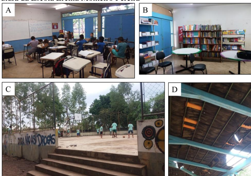
Figura 3 – Estrutura da Escola Ercina Monteiro Pereira
