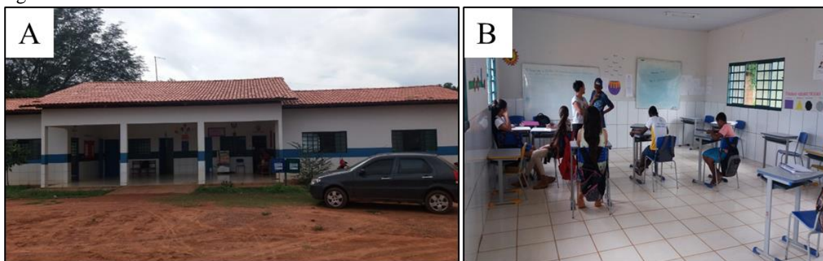
Figura 5 - Estrutura da Escola Pau D'arco
