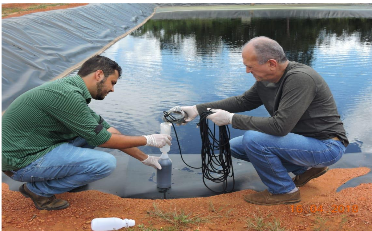
Figura 6.15: Coleta da amostra de percolado no sistema de tratamento instalado na área do Aterro Sanitário de Palmas - TO.
