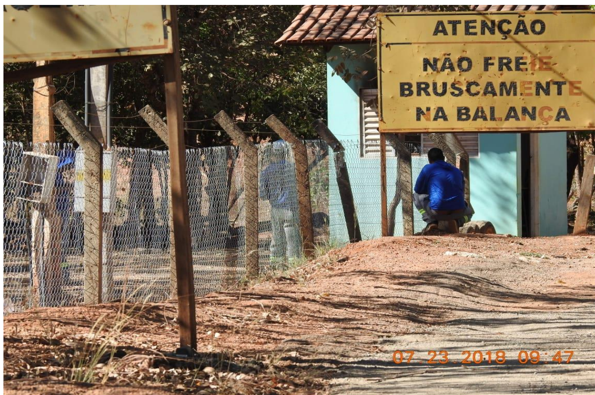
Figura 6.6: Visão Frontal da área de pesagem do Aterro Sanitário de Palmas - TO.
