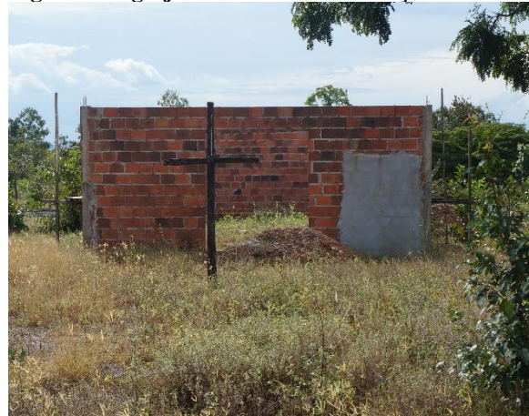
Figura 4 – Igreja Católica em construção
