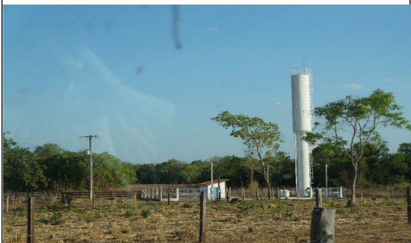
Figura 16 – Reservatório de água do (re) assentamento Flor da Serra
