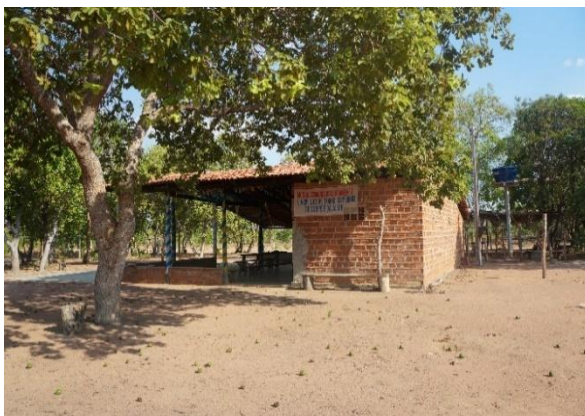
Figura 40– Prédio da Associação
