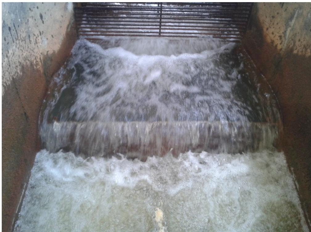
**Figura 4.3:** Vertedor após o canal Parshall na ETA de Porto Nacional.
