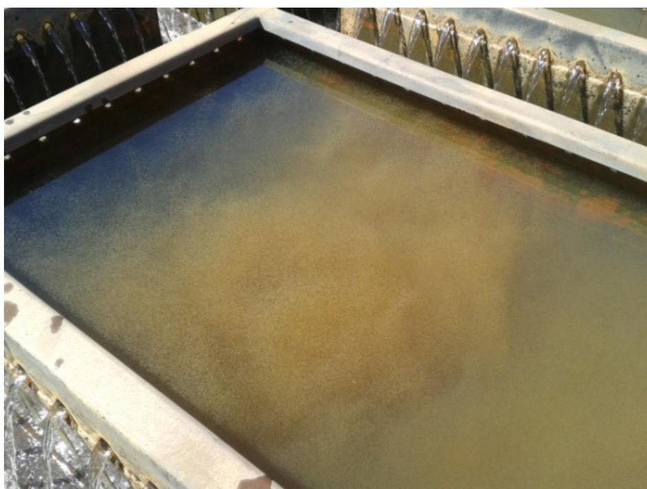
**Figura 5.12:** Desprendimento de flocos do FAP 004 após o reinício de operação após lavagem do FRD 004.
