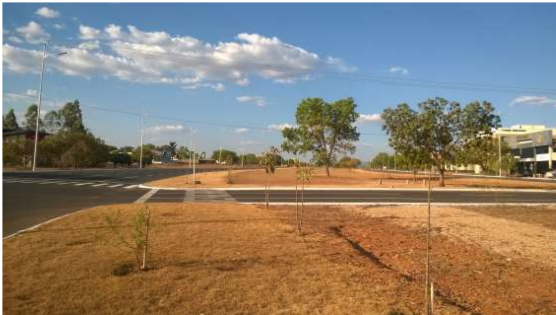
Figura 15- Canteiro central da Av. Teotônio Segurado desmatado.
