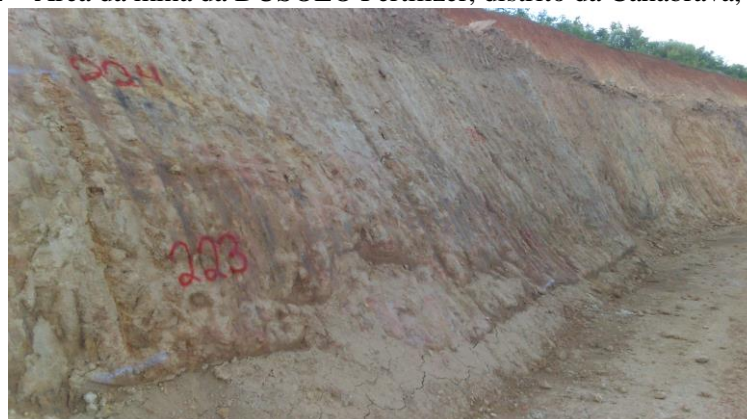
Figura 24 – Área da mina da DUSOLO Fertilizer, distrito da Canabrava, Arraias-TO
