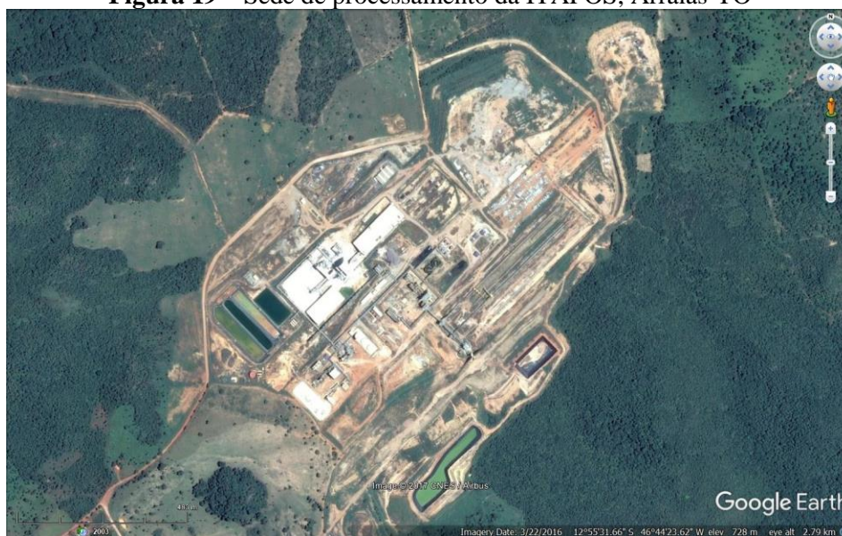
Figura 19 – Sede de processamento da ITAFOS, Arraias-TO
